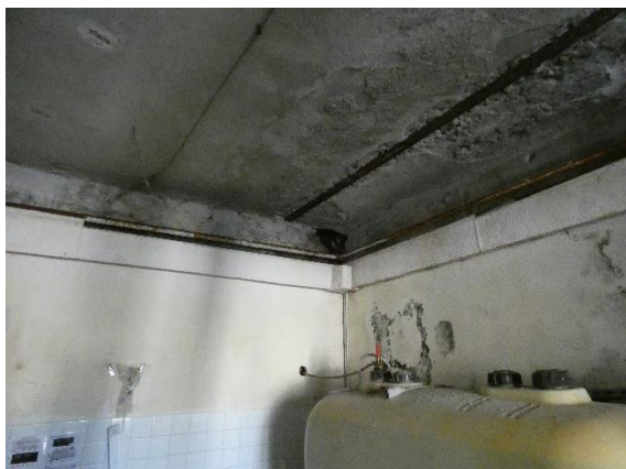
Niveau -1 du bâtiment – peu favorable
