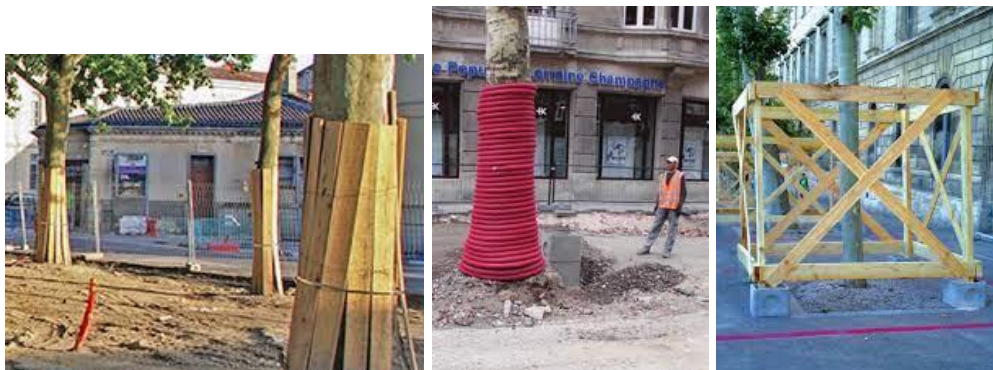
Exemples de protections des arbres
